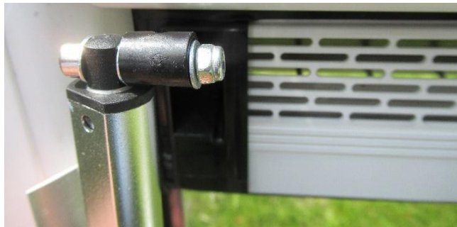
Directe aansluiting van de actuator op het oog van een handle van een (Duco) kleprooster
