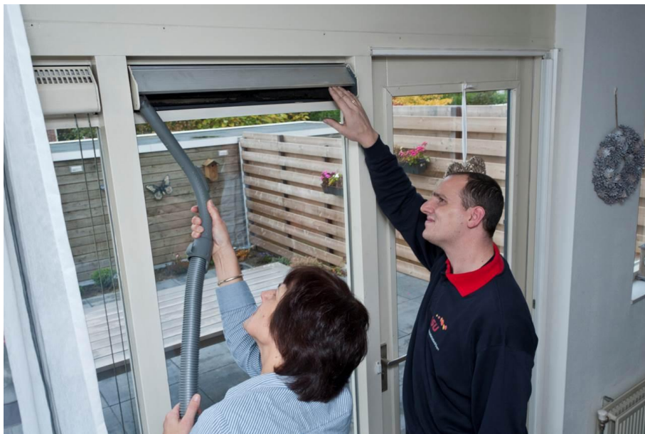
Reinigen van de bestaande raamroosters
