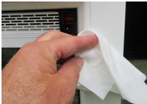
Ontvetten van kozijn en draaiknop voor het aanbrengen van montagetape.
