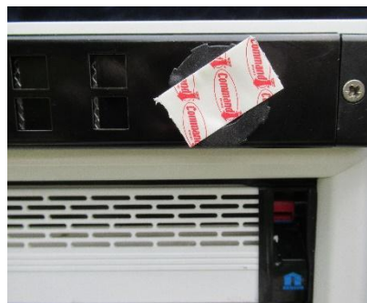
Ontvetten van kozijn en draaiknop voor het aanbrengen van montagetape.
